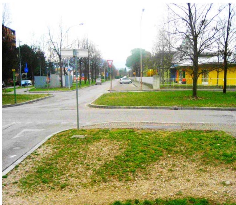
Situazione prima dell'intervento
