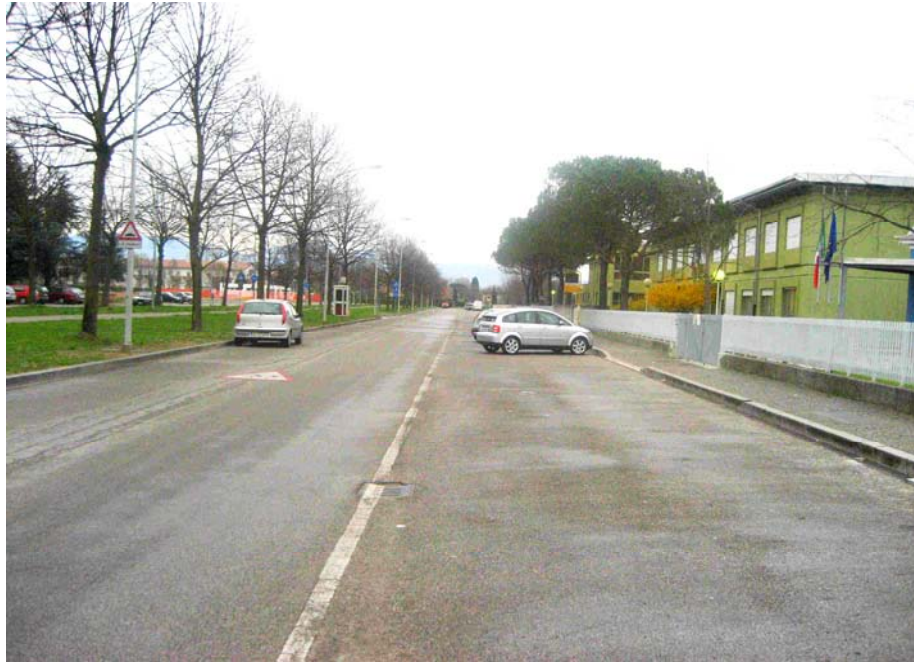
Situazione prima dell'intervento
